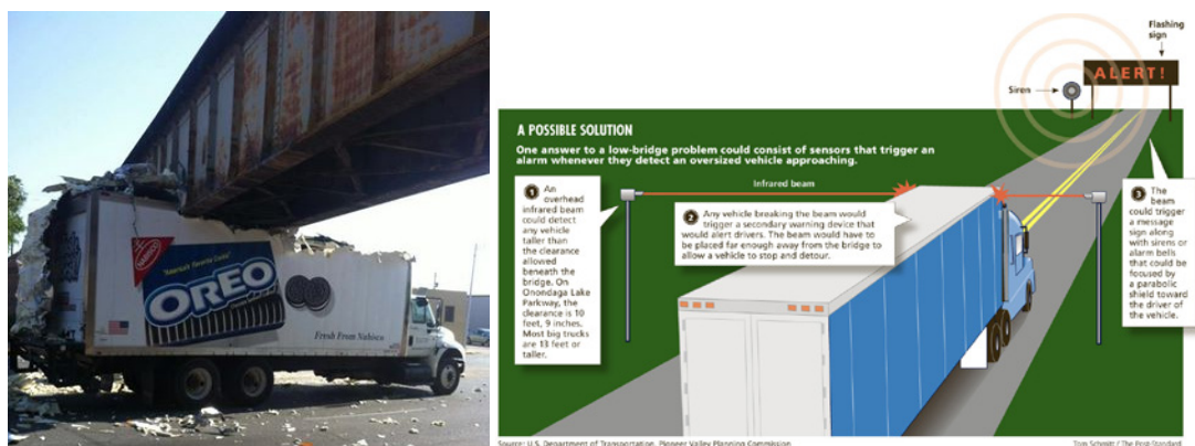
Rys. 2. System kontroli wysokości pojazdów przed wjazdem pod most wykorzystujący aktywną podczerwień [6, 7]
